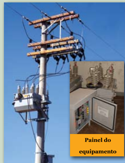
Religador instalado na rede de distribuição da Cemirim
