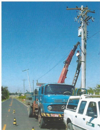
Técnicos da Cemirim instalam os novos postes de concreto
