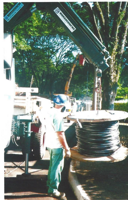
... e se preparam para fazer a troca por cabos isolados
