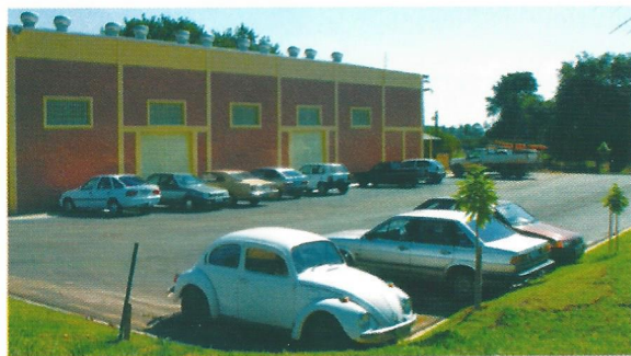
Estacionamento completamente asfaltado
