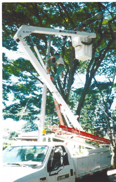
Após a troca dos postes, técnicos da Cemirim instalam os conjuntos de iluminação...
