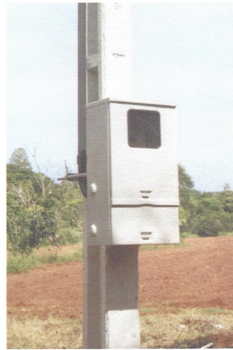
O mesmo padrão, depois da reforma realizada pela Cemirim, com novo postinho, fiação e caixa
