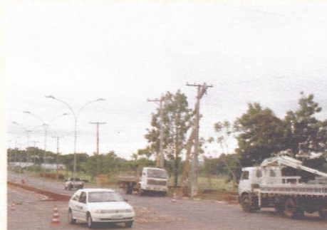
Novos postes de iluminação (ao fundo) e equipe técnica da Cemirim fazendo remanejamento dos postes existentes
