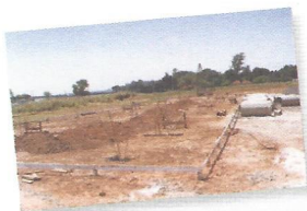
Obras da nova subestação em fim de setembro...
