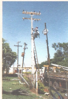
Funcionários da Cemirim fazem concertos nas redes de transmissão
