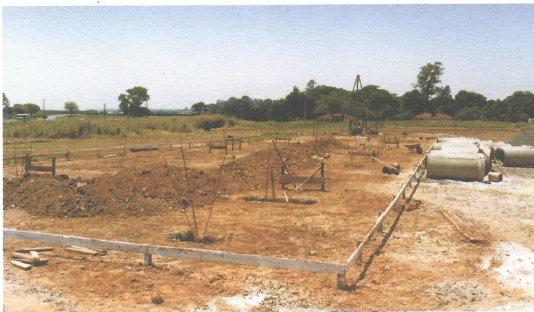
Obras de fundação da nova subestação, em fins de setembro
