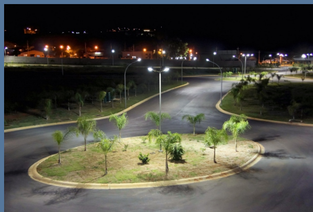
Infraestrutura Subterrânea Condomínio Flor D'Aldeia - Holambra
