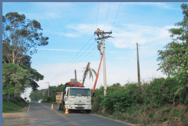
Recondutamento e instalação de cabo isolado - Bairro Pinhalzinho
