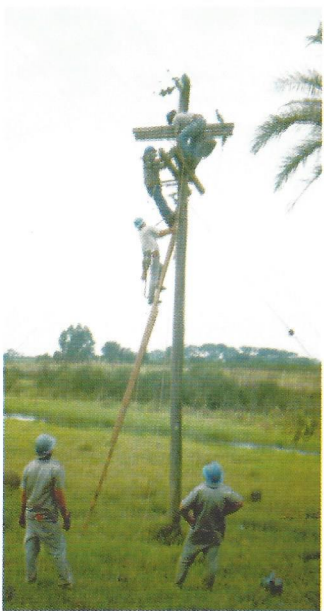
Poste com cruzeta sendo instalado em área rural: mais segurança
