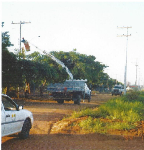
Técnico retira luminária de poste antigo para instalá-la no poste de concreto, à direita
